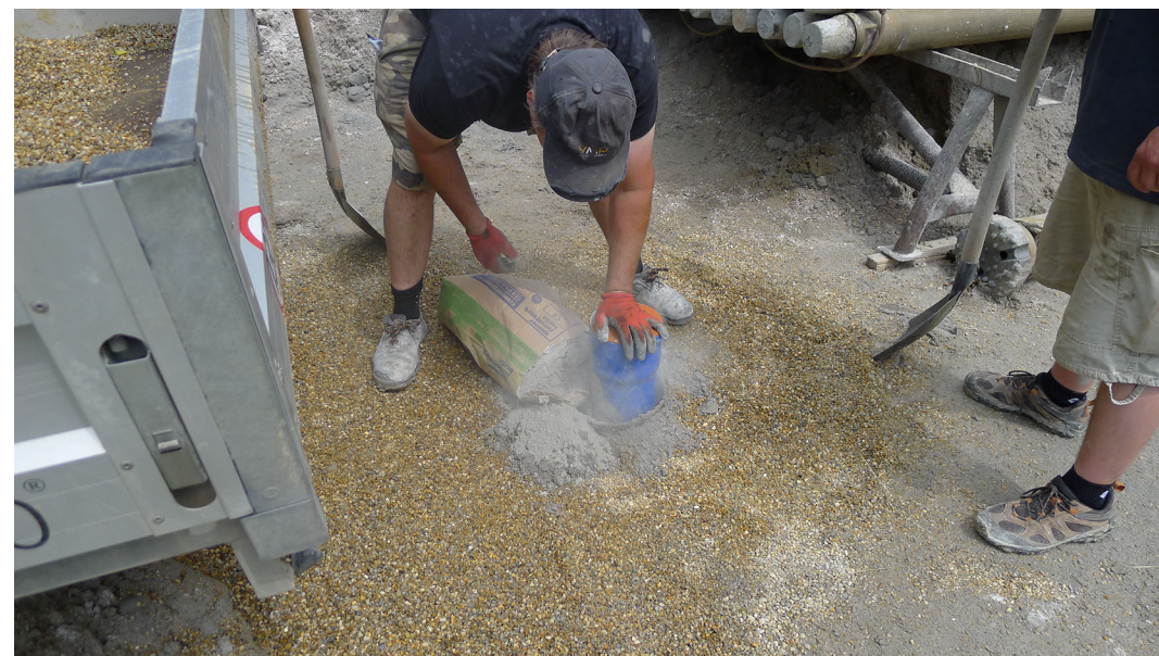
Obr. 12 Cementace vrtu
