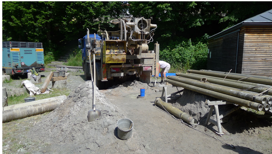
Obr. 14 Vystrojený vrt
