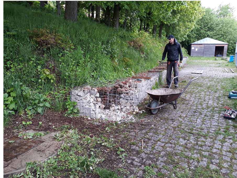
Obr. 2 Rozebírání gabionové zídky
