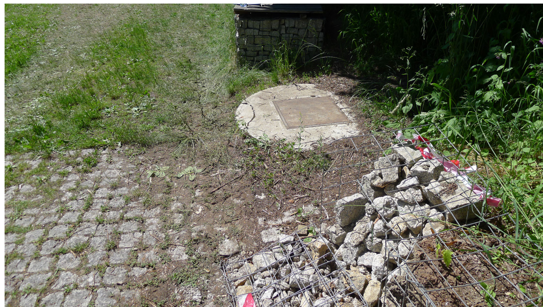
Obr. 6 Poškozená skruž po průjezdu vrtné soupravy
