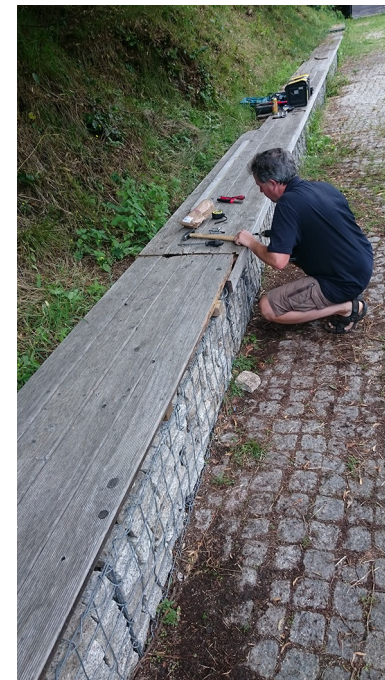
Obr. 26 Montáž gabionové zídky
