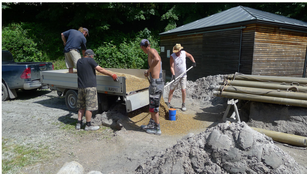
Obr. 11 Obsypávání vrtu
