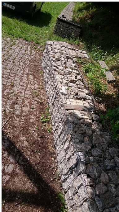
Obr. 3 Rozebírání gabionové zídky
