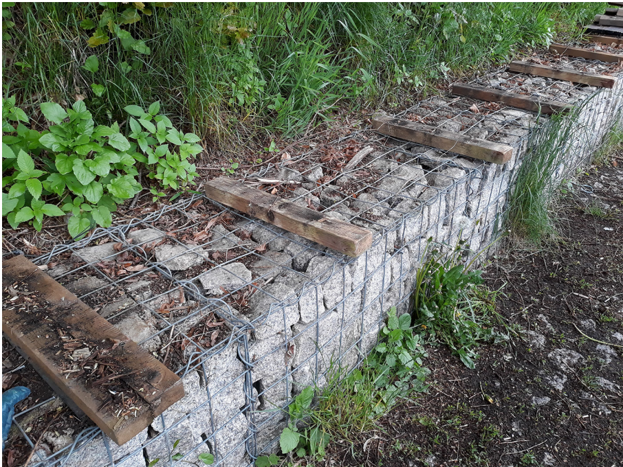
Obr. 1 Rozebírání gabionové zídky
