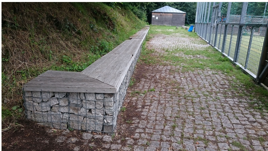
Obr. 27 Gabionová zídka - finální podoba
